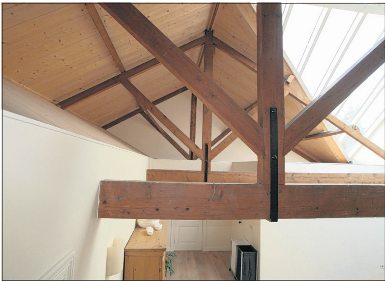
Houtwerk in boerderij de Engh.
